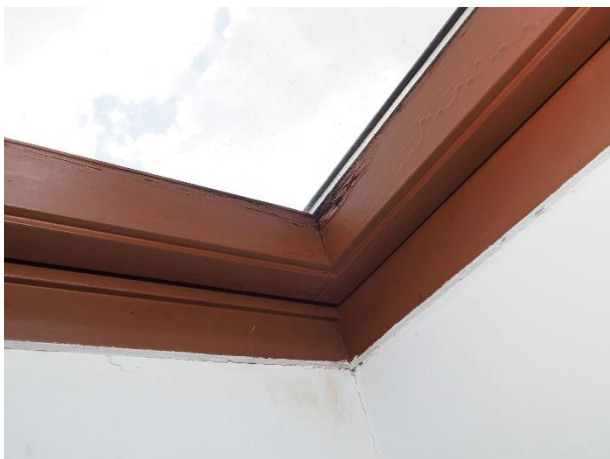
Fot. 10. Okno dachowe porażone przez grzyby rozkładu szarego
