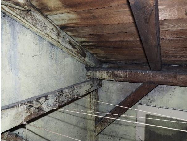
Fot. 4. Drewniane elementy więźby dachowej – widoczne ślady farby ogniochronnej
