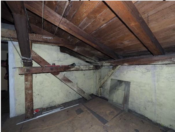
Fot. 9. Widoczne grzyby rozkładu brunatnego na odeskowaniu
