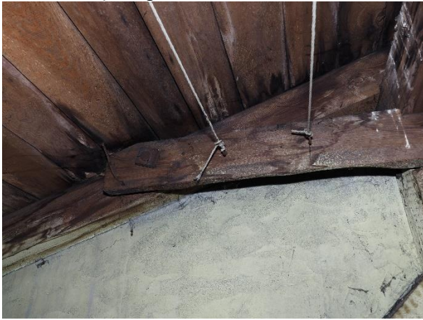
Fot. 8. Widoczne grzyby rozkładu brunatnego na odeskowaniu
